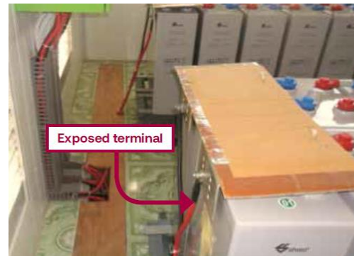
कार्डबोर्डको प्रयोगले ब्याट्री टर्मिनलहरू ढाक्ने गरेको छ । अस्थायी समाधान टर्मिनलहरू अलग गर्न पर्याप्त छैन ।
