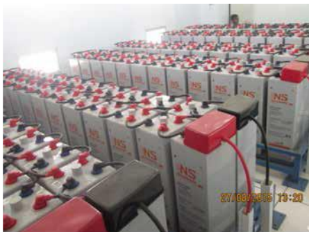
ब्याट्री टर्मिनलहरूलाई इन्सुलेटरले (Insulated material) सुरक्षित र केबुलहरू राम्ररी जडान गरिएको छ ।
