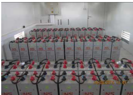
ब्याट्री स्ट्रिङहरू (Battery strings) zig-zag तरिकामा र भेन्टिलेसन (Ventilation) को साथमा प्रत्यक्ष सूर्यको जोखिमबाट बच्न स्थापना गरिएको छ ।
