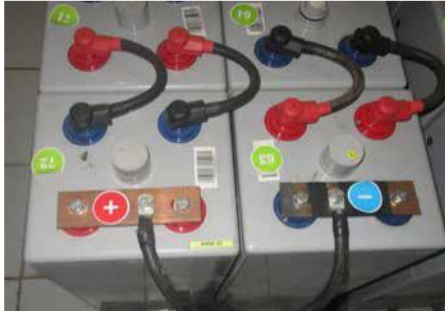
ब्याट्री टर्मिनल राम्रो अवस्थामा भएको खिया वा सल्फेट फ्लेक्स (Sulphate flakes) बाट मुक्त गरिएको छ ।
